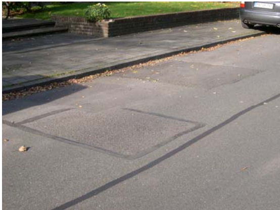
Abb. 9.1.-1: Flickschäden
